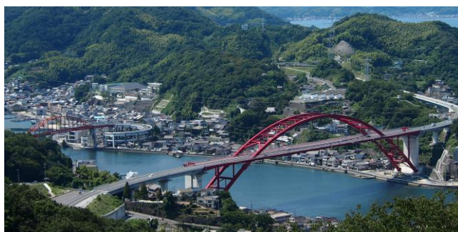
第二音戸大橋
