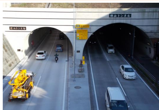
長迫側トンネル抗口
