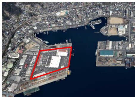
呉市地方卸売市場
