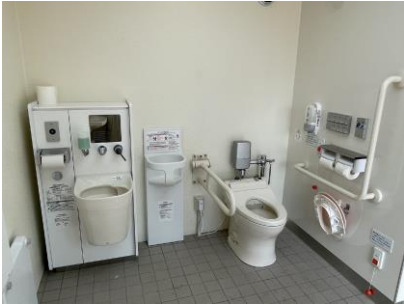
公園内の障害者用トイレ
