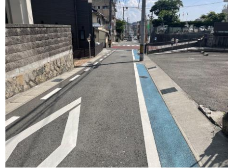
カラー舗装による空間確保
