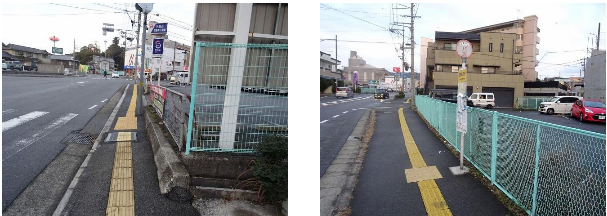
図 6 4 昭和市民センター周辺地区の状況
