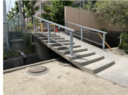
スロープ補修予定箇所（勾配調整）
