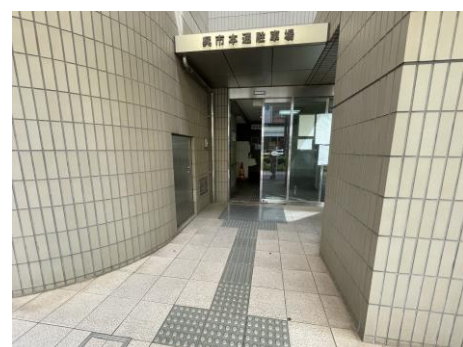
視覚障害者誘導用ブロック
