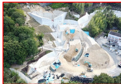
92隣e (本堤、前庭保護工完成) (⑤堆積工、流木補足工完成 管理用道路工事中)
