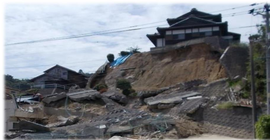
【蒲刈町田戸】がけ崩れ
