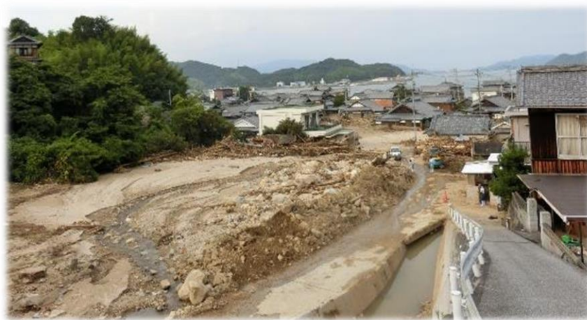
【音戸先奥3丁目】土石流
