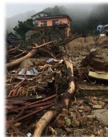
【阿賀南9丁目】土石流
