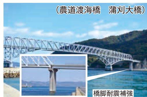
（農道渡海橋 蒲刈大橋） 橋脚耐震補強
