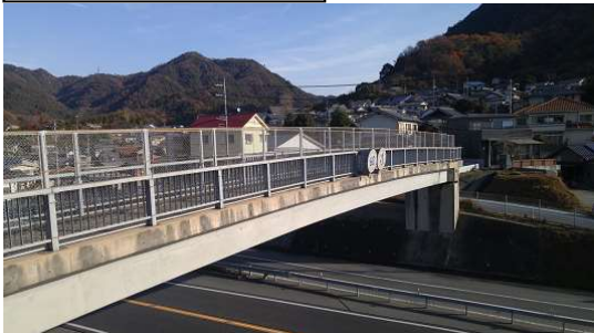
天應山陸橋 L=39.9m (PC橋)1988年架設
