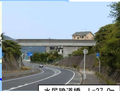
水尻跨道橋 L=27.0m (PC橋)1998年架設
