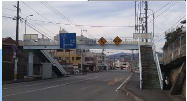
畑横断歩道橋 L=41.6m (鋼橋)1969年架設
