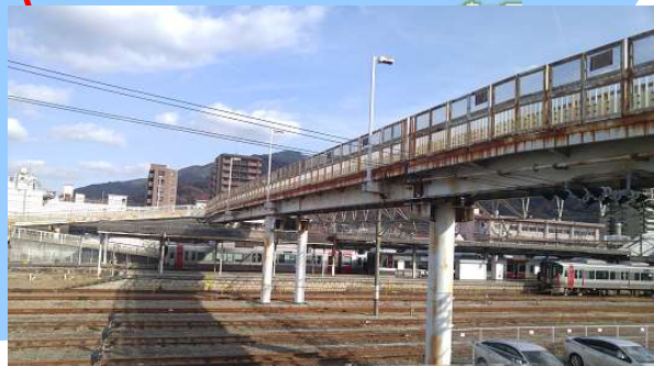
広駅跨線橋 L=278.6m (鋼橋)1987年架設
