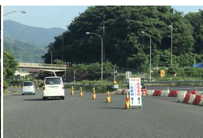
バス等専用レーンの設置 (広島呉道路 坂北料金所～坂北 IC に設置)
