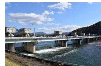
広島水道用水供給事業の取水施設 (高瀬堰：広島市安佐北区)
