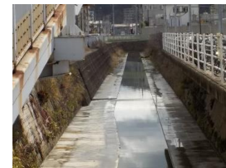
整備後の広雨水1号幹線 （免田川）
