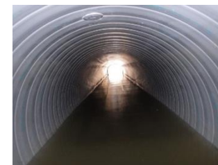
更生工事完了後の下水道管
