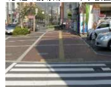
<歩道の誘導用ブロック設置>
