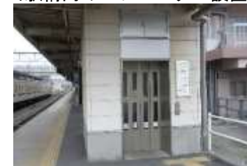
<駅構内のエレベーター設置>
