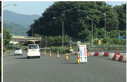
バス等専用レーンの設置（広島呉道路坂北料金所～坂北 IC に設置）
