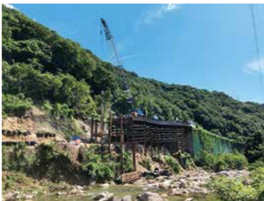
上二河の橋梁工事に着手
