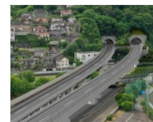
広島呉道路の4車線化
