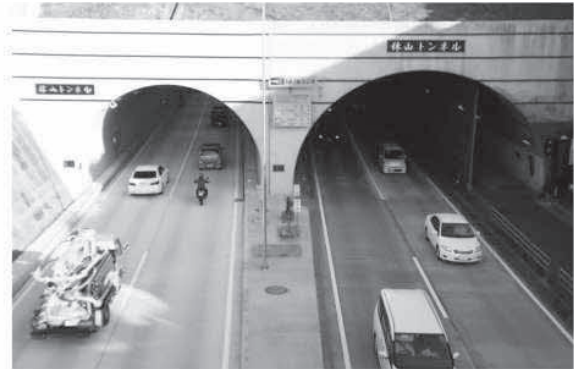
4車線化完成後の状況
