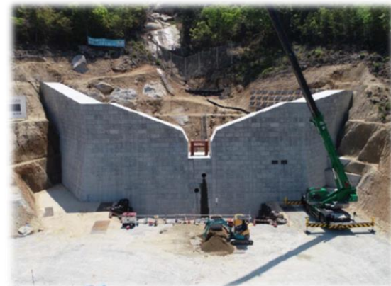
整備中の砂防堰堤 (大屋大川(3-81-92隣e)) 〔天応中学校東側〕
