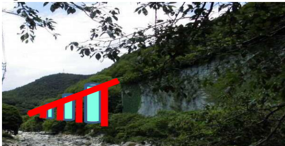
② 橋りょう下部工
