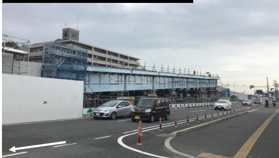
橋桁架設(A2橋台～P5橋脚間)
