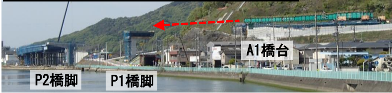
A1橋台～P2橋台 橋桁架設工事 (送り出し)
