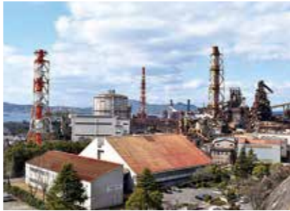
閉鎖方針の瀬戸内製鉄所呉地区
