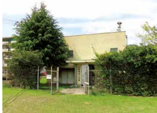
廃止する三坂地ポンプ所
