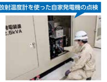
放射温度計を使った自家発電機の点検
