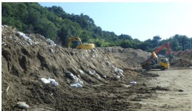
住民用仮置場（梅木町内広場）平成30年度撮影
