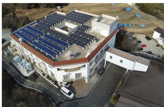
改修後の特別養護老人ホームコスモス園別館
