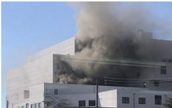
クリーンセンターくれの火災
