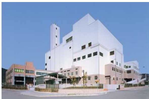
クリーンセンターくれ
