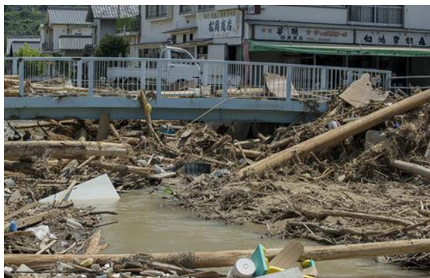
広島県呉市安浦町の土砂災害河川（平成30年7月9日）
