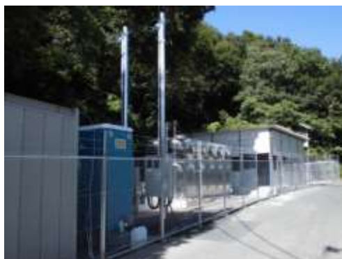
仮設ポンプ所
