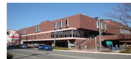
6 呉信用金庫ホール (呉市文化ホール)
