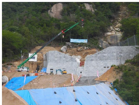
【大屋大川支川溪流砂防堰堤】（天応中学校）
