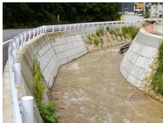
【大屋大川復旧工事】
