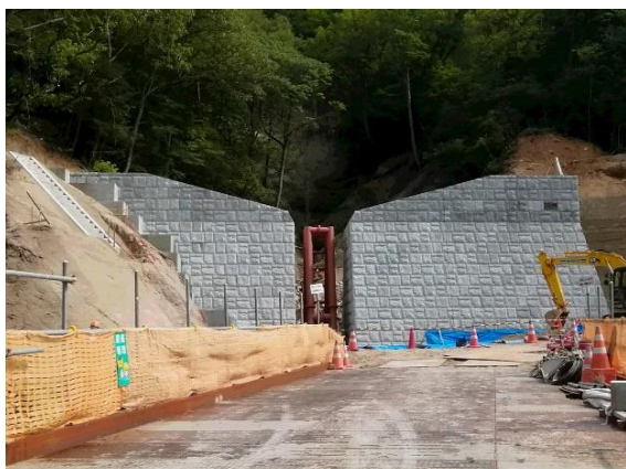
【大屋大川溪流砂防堰堤】
