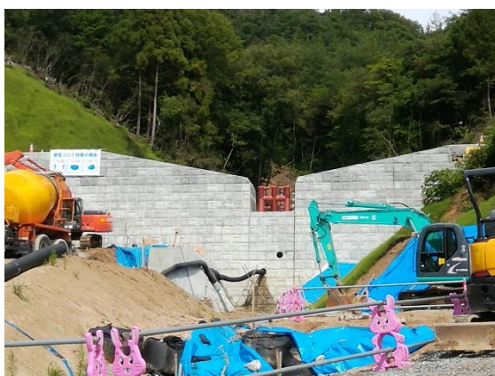
【背戸ノ川支川砂防堰堤】
