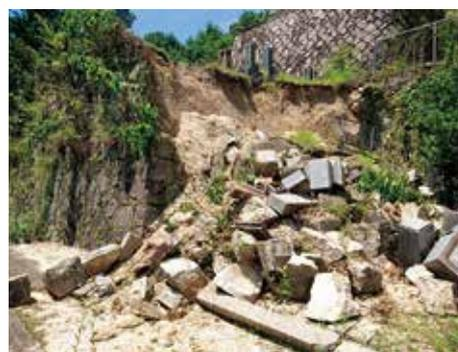
△山間部や傾斜地に造成されている墓地施設は、法面の崩落などにより墓石の倒壊など大きな被害が発生した。
