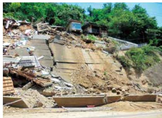
◁△ 斜面崩壊により県道へ崩れ落ちた家屋
