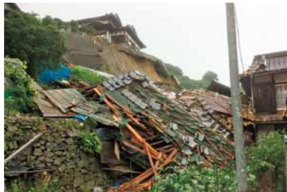
擁壁の崩落により倒壊した家屋
