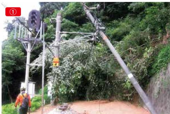
① 土砂流入により倒壊したコンクリート柱(天応駅付近)
