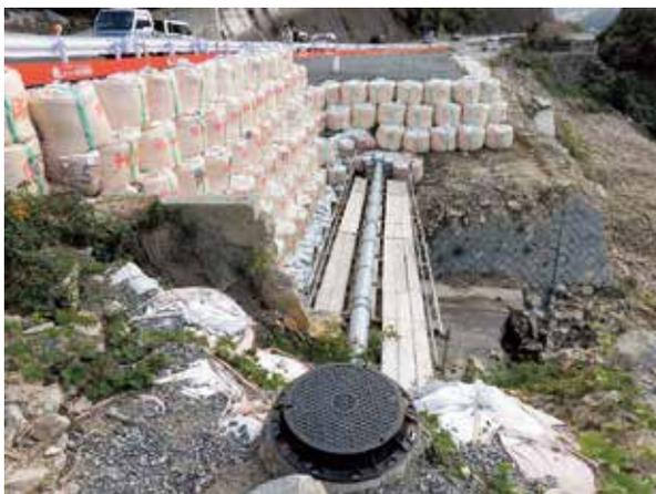
石内郷原污水幹線の仮配管(国道375号上段原橋)
