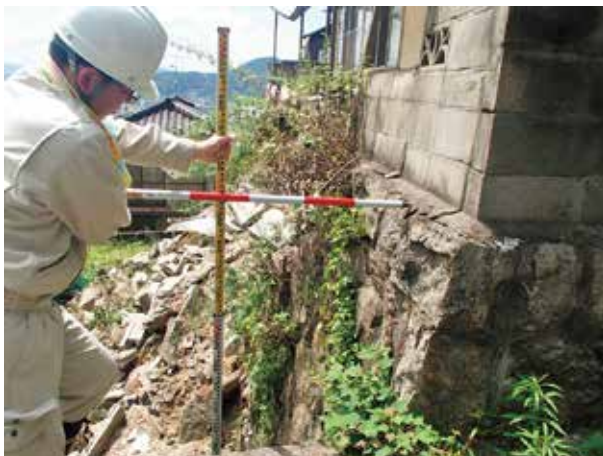
職員による被災した宅地崖の調査(7/10撮影)
