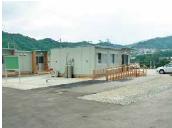
建設型応急仮設住宅(安浦地区)
