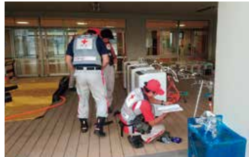
日本赤十字社による洗濯機設置作業
