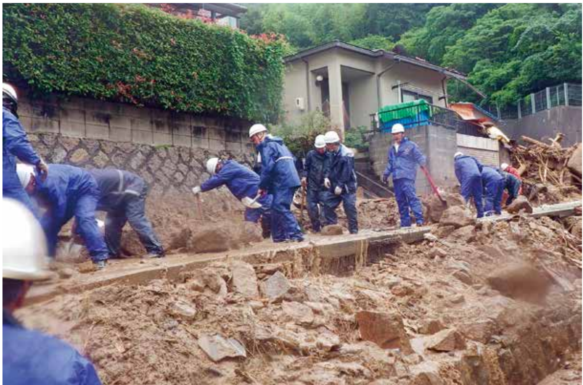
水の流れをつくるため、懸命な手掘り作業を繰り返す消防団員(湾岸分団)
