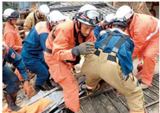
屋根から1階の要救助者を救出する消防隊員
