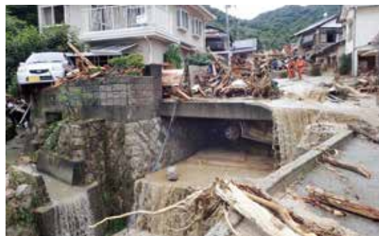
土石流により流された家屋や自動車
