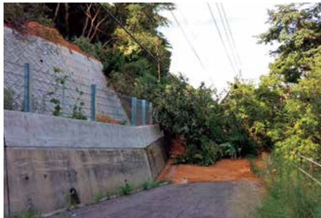
斜面崩落による電柱の倒壊(倉橋町大向～西宇土間)
