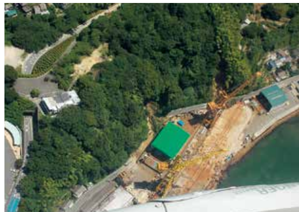
主要地方道 呉環状線(警固屋8丁目付近)
