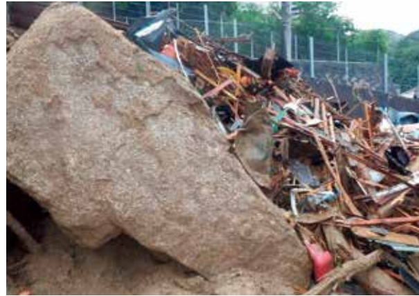
巨石により倒壊した家屋
