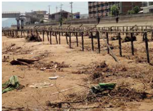
被災現場(黒瀬川河口・8/8撮影)
