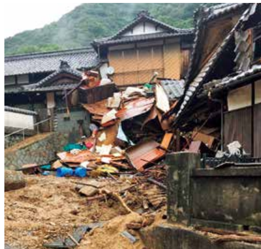
倒壊した家屋と道路上に流入した土砂
