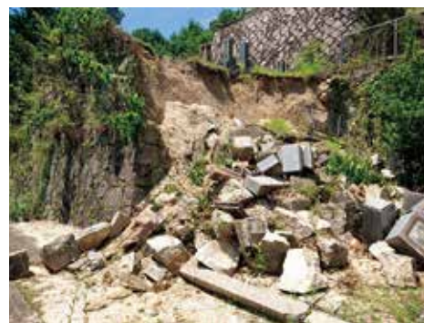
△山間部や傾斜地に造成されている墓地施設は、法面の崩落などにより墓石の倒壊など大きな被害が発生した。 写真は塩屋墓地の被災状況(7/9撮影)
