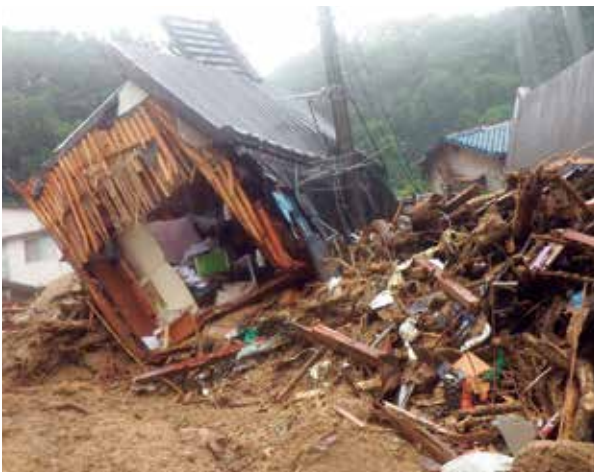
土石流により倒壊した家屋
