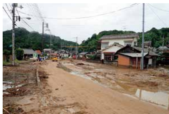
大規模な土石流により土砂が流入した国道487号
