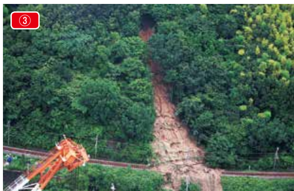
崩落土で遮られた線路(安登駅付近)
