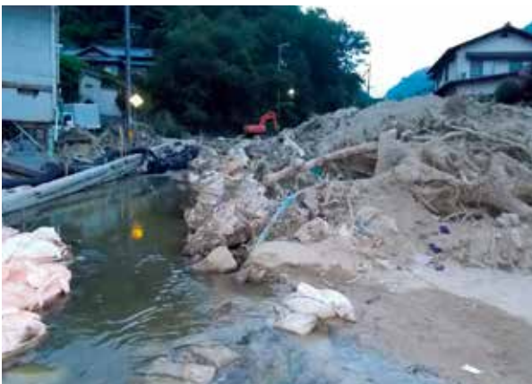
主要地方道 呉環状線(天応～焼山間)
