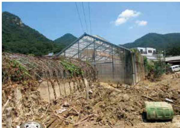
被災現場(天応西条2丁目・7/25撮影)
