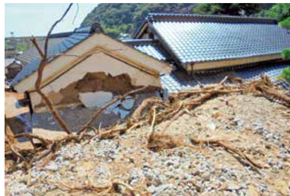
土砂による家屋の損壊
