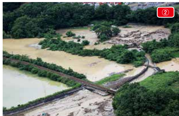
土砂や倒木が流入した線路(仁方駅付近)
