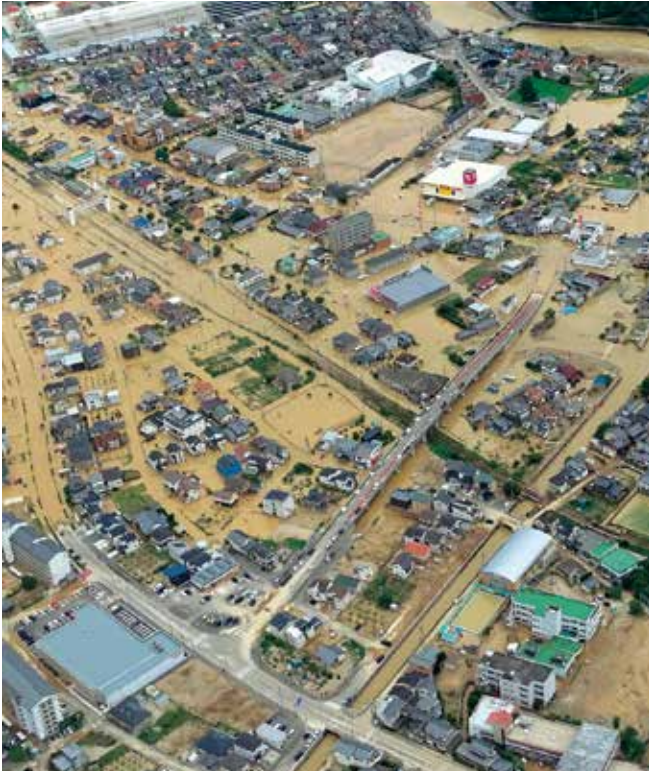
河川の氾濫により多数の家屋が浸水
