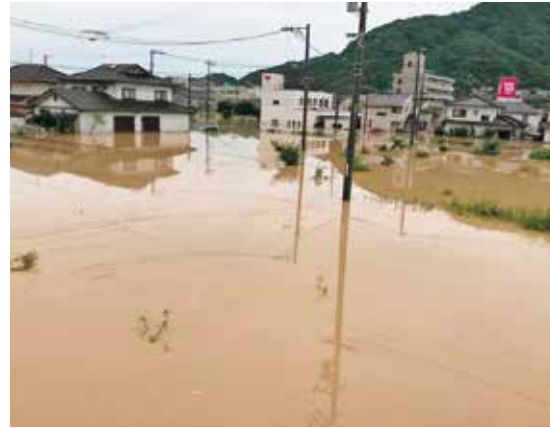
道路の境界が分からなくなるほどの浸水が発生
