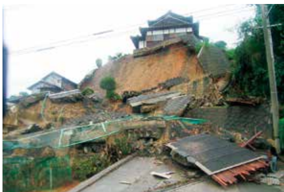
家屋下の擁壁が崩落
