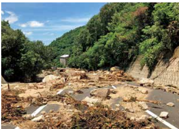
土石流により崩壊した大屋大川上流(主)呉環状線
