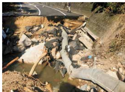
天応焼山污水幹線の被災状況(管きよの破断)
