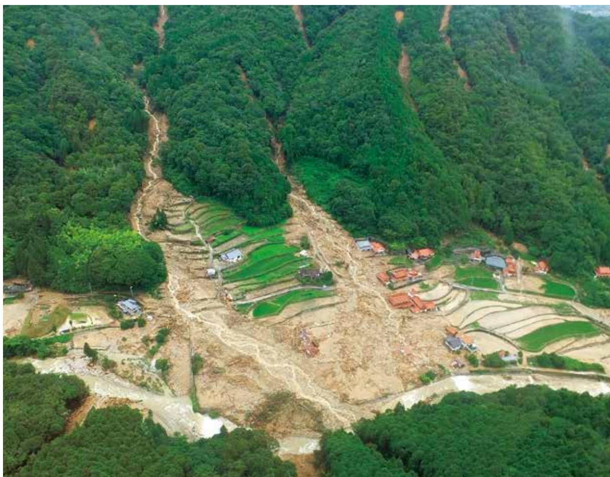
土石流の発生により大量の土砂や流木に飲み込まれた市原地区の家屋や農地
