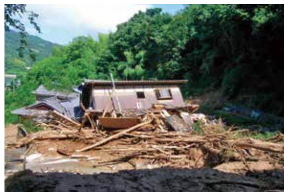
隣家へ押し倒された倒壊家屋
