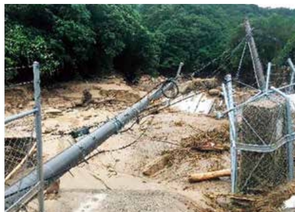
被災後の柳迫第1ポンプ所
