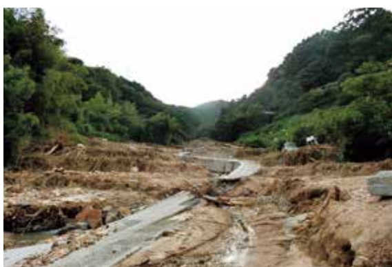
土石流によって崩壊した道路・河川
