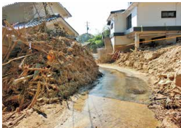
道路下の水路が閉塞し団地内へ土石流が流入(写真提供：呉工業高等専門学校)
