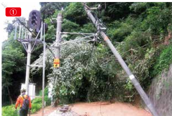
土砂流入により倒壊したコンクリート柱(天応駅付近)
