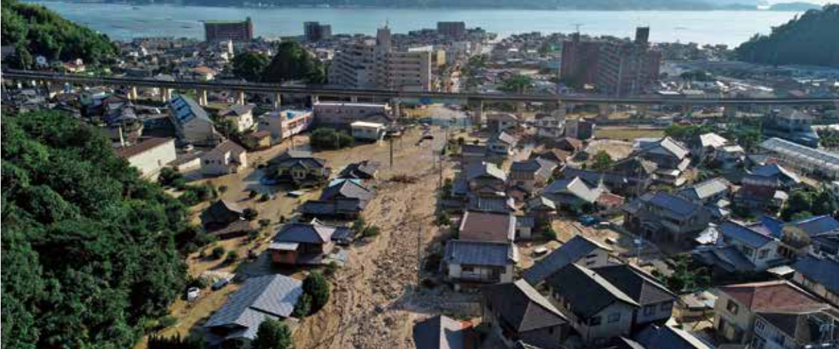
土砂・洪水氾濫が発生し、住宅地に堆積した大量の土砂(天応地区の中心部・7/9撮影)
