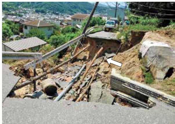
道路の崩落により露出したガス管(吉浦上城町)
