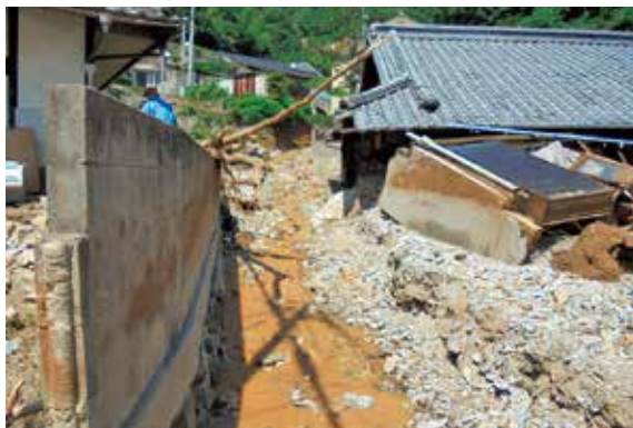
住宅地に流入した土砂
