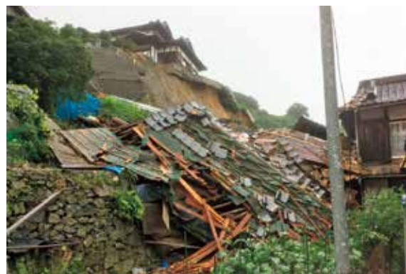
擁壁の崩落により倒壊した家屋
