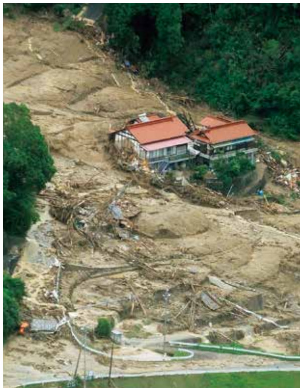
土石流により携帯電話基地局や電気設備も損壊
