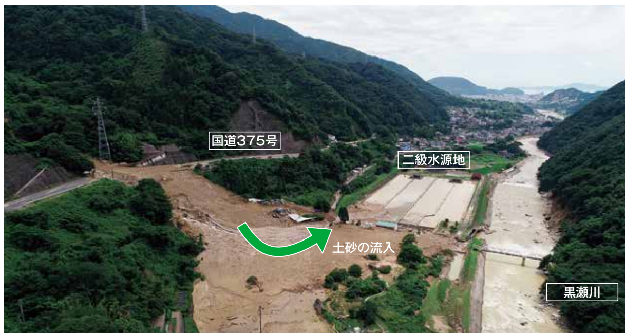
土砂の流入により機能を停止した二級水源地
