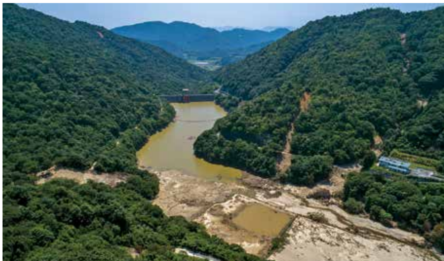
土砂等が流入した野呂川ダム(8/4撮影)
