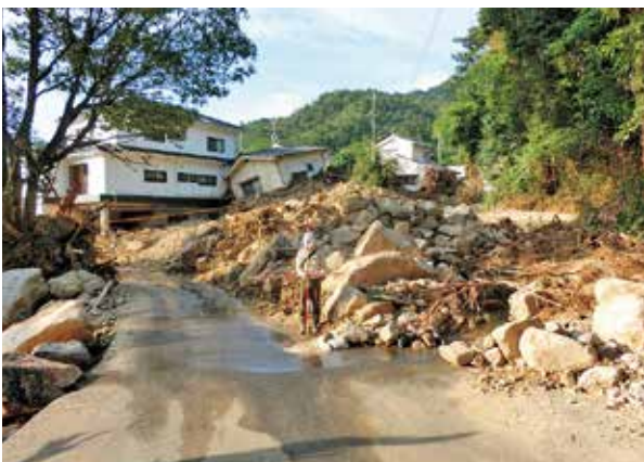
道路下の水路が閉塞し団地内へ土石流が流入(写真提供：呉工業高等専門学校)
