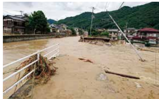
破堤した中畑川左岸
