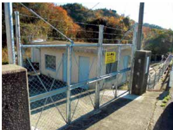
被災前の柳迫第1ポンプ所
