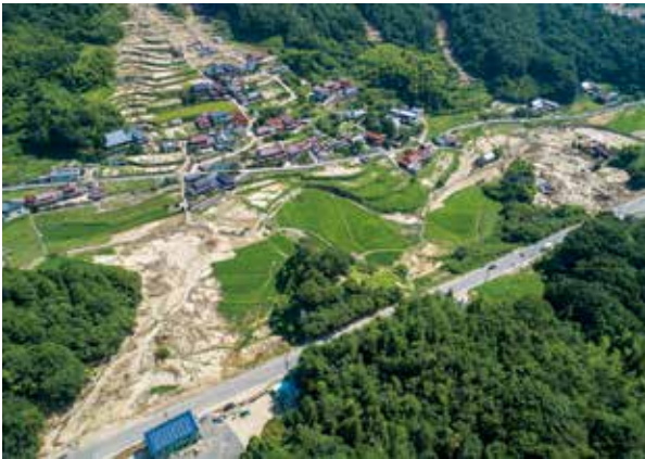
大量の土砂が流入した農地(中畑地区)
