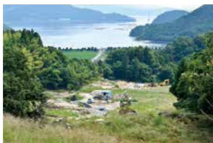
災害復旧を進める日之浦地区
