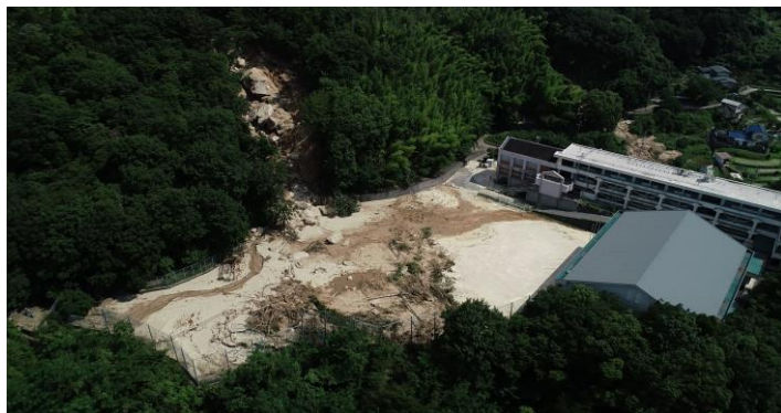
天応中学校の被災状況
