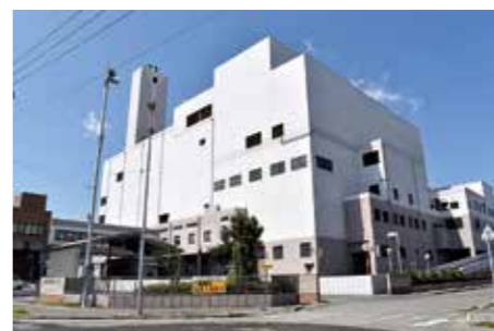
クリーンセンターくれ
