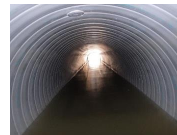
管更生工事後の下水道管
