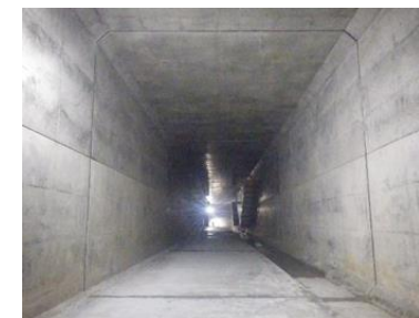
雨水を溜める貯留施設 （広東地区雨水貯留施設の内部）
