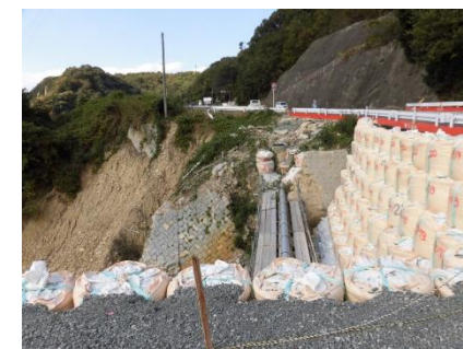
石内郷原汚水幹線（仮復旧）
