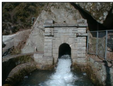
二河水源地取入口
