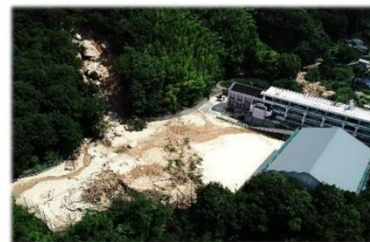
【被災した天応中学校】
