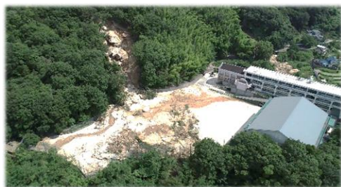
▲被災した天応中学校
