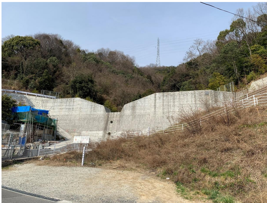
▲砂防えん堤の整備事例
