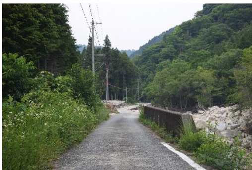
▲西側 野呂山方面の道路現況
