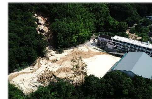
【被災した天応中学校】
