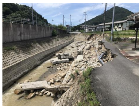
被災した市道東麻畠梶耶線と二級河川中切川
