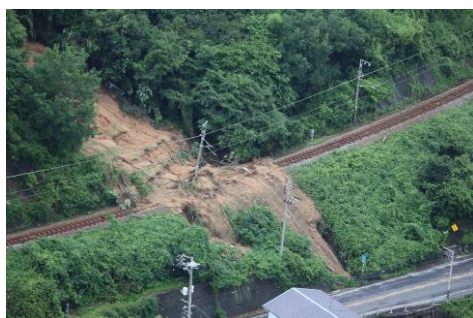
JR呉線 安登～安芸川尻駅間 斜面崩壊 （写真提供：西日本旅客鉄道（株））
