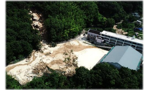
【被災した天応中学校】
