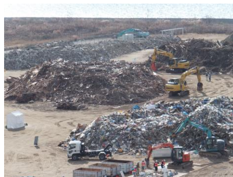
災害廃棄物の処理状況
