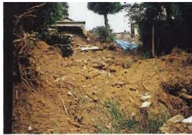
被災人家より見た斜面状況
