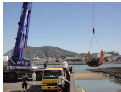
かき抑制柵周辺の土砂・流木の撤去作業（黒瀬川河口）
