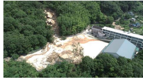
天応中学校の被災状況
