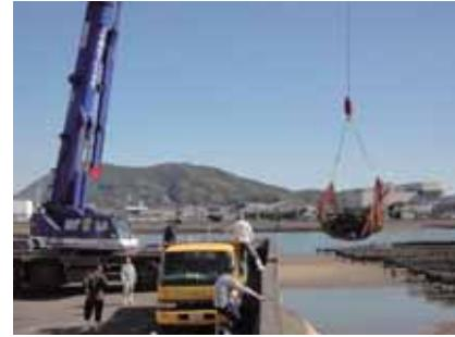
かき抑制棚周辺の土砂・流木の撤去作業（黒瀬川河口）
