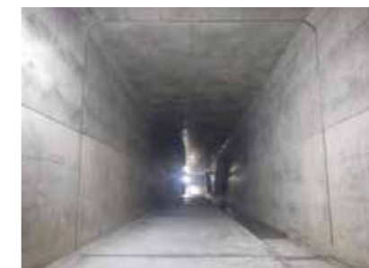
▲雨水を溜める地下貯留施設【広東地区雨水貯留施設の内部】(幅・高さ:6.5m、長さ:106m)
