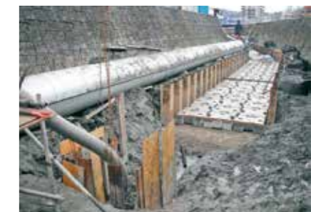
▲川底の勾配修正工事【広雨水1号幹線】
