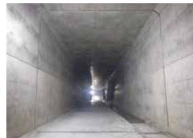
▲雨水を溜める地下貯留施設【広島地区雨水貯留施設の内部】(幅・高さ:6.5m、長さ:106m)
