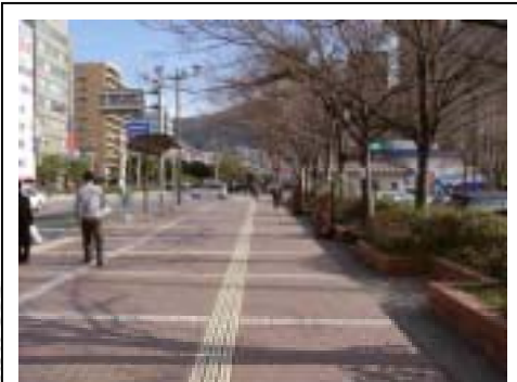
○歩道幅員は広く、目立つ色の視覚障害者誘導用ブロックが敷設されている。
