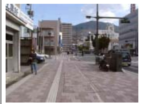
○歩道幅員は広く、目立つ色の視覚障害者誘導用ブロックが敷設されている。
