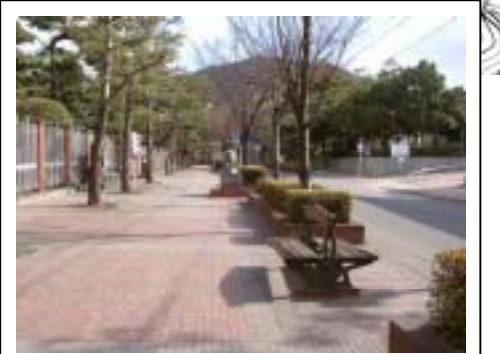
○幅員は広く休憩用のベンチも設置しており、快適な歩行空間である。視覚障害者誘導用ブロックは、反対側車線の歩道に敷設されている。
