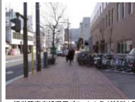
視覚障害者誘導用ブロックの色が舗装と同系色である。
