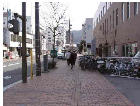
●視覚障害者誘導用ブロックの色が舗装と同系色である。
