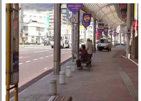
○アーケードによって、天候に依存しない快適な歩行環境を提供している。 ●視覚障害者誘導用ブロックの色が舗装と同系色である。 ○バス停にはベンチが設置されている。
