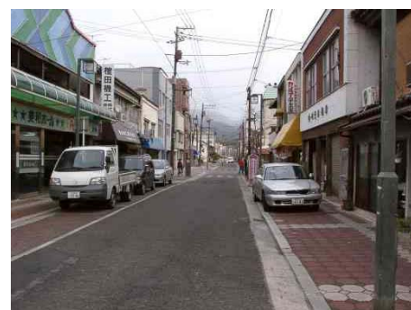
○コミュニティ道路※6として整備済である。 ●車止めが少なく歩道上への駐車が多い。 ●視覚障害者誘導用ブロックが敷設されていない。
