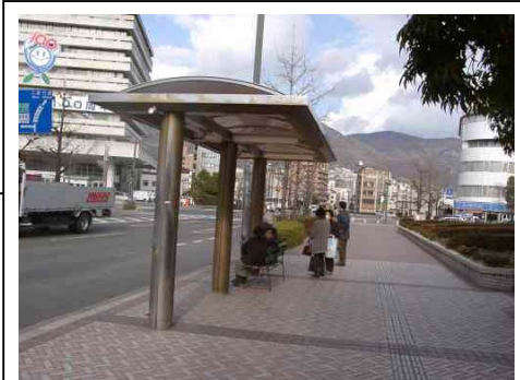
●視覚障害者誘導用ブロックの色が舗装と同系色である。 ○バス停には屋根やベンチが設置されている。
