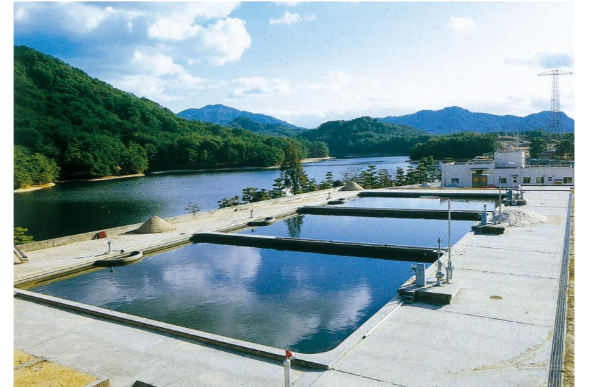
▲昭和56年に完成した本庄浄水場
