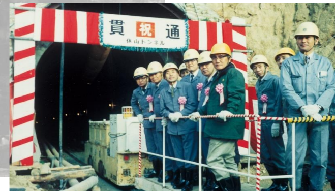
▲休山隧道配水池貫通式（昭和47年12月25日）
