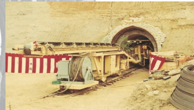
▲工事で使用されたトンネル・ボーリング・マシン
