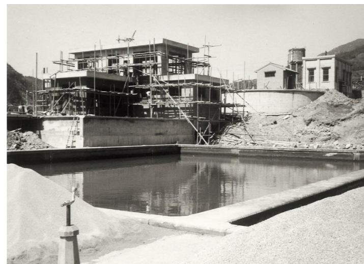
▲石内浄水場管理棟建設工事〈昭和40年頃〉
