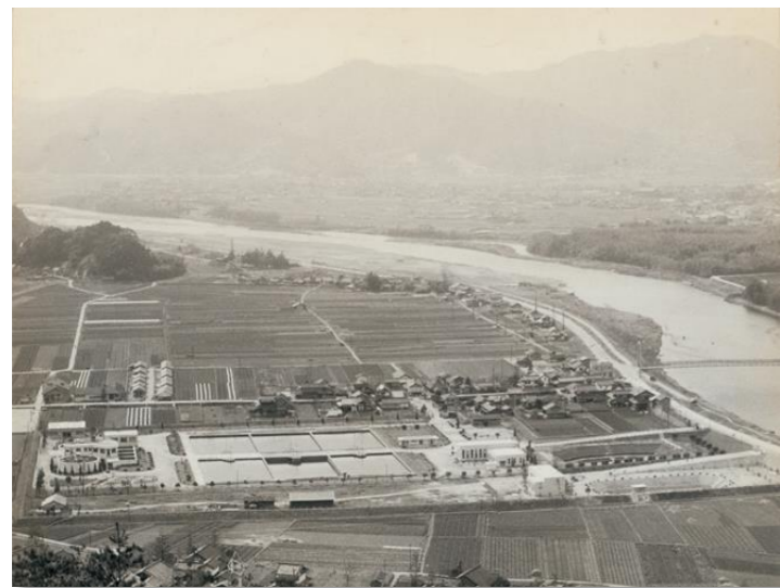
▲昭和36年の戸坂浄水場
