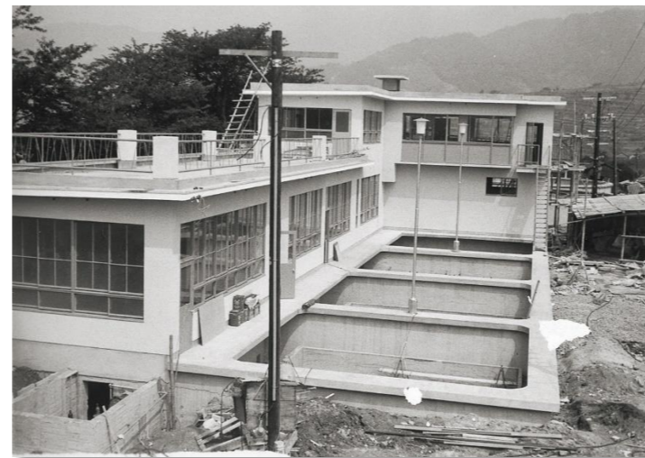
▲平原浄水場管理棟と急速ろ過池建設工事〈昭和39年頃〉
