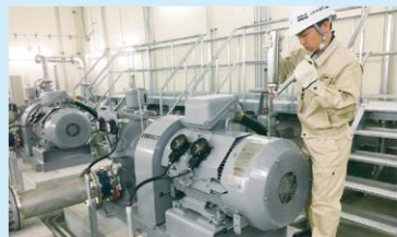
▲ポンプのモーターへのグリス注入作業
