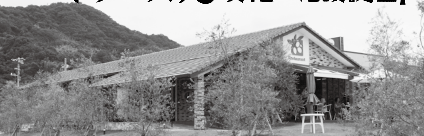
オリーブの木と芝生に囲まれ、開放的で洒落な雰囲気の江田島オリーブファクトリー
