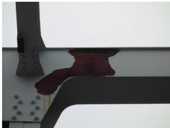
鹿島大橋 塗装剥離状況
