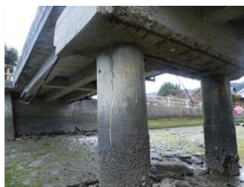
西新開中道線1号橋 橋脚頭部の剥離・鉄筋露出 H27年度架け替え(歩道橋化)
