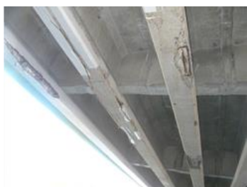
宝橋 主桁(PC桁)の剥離・鉄筋露出 H26年度架け替え
