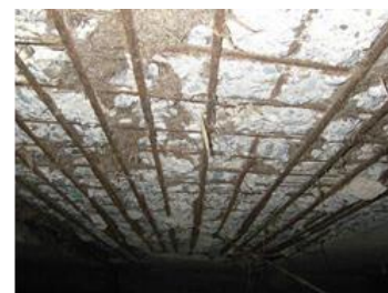
役所橋 コンクリート床版の剥離・鉄筋露出 H28年度架け替え
