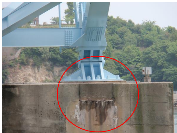
蒲刈大橋 P3 橋脚 遊離石灰発生状況
