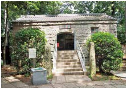
明治35(1902)年、陸軍が建設した高鳥砲台跡から移築復元した総石造りの火薬庫。南北棟の切妻造れ葺きで、桁行9.7m、梁間4.2m。
