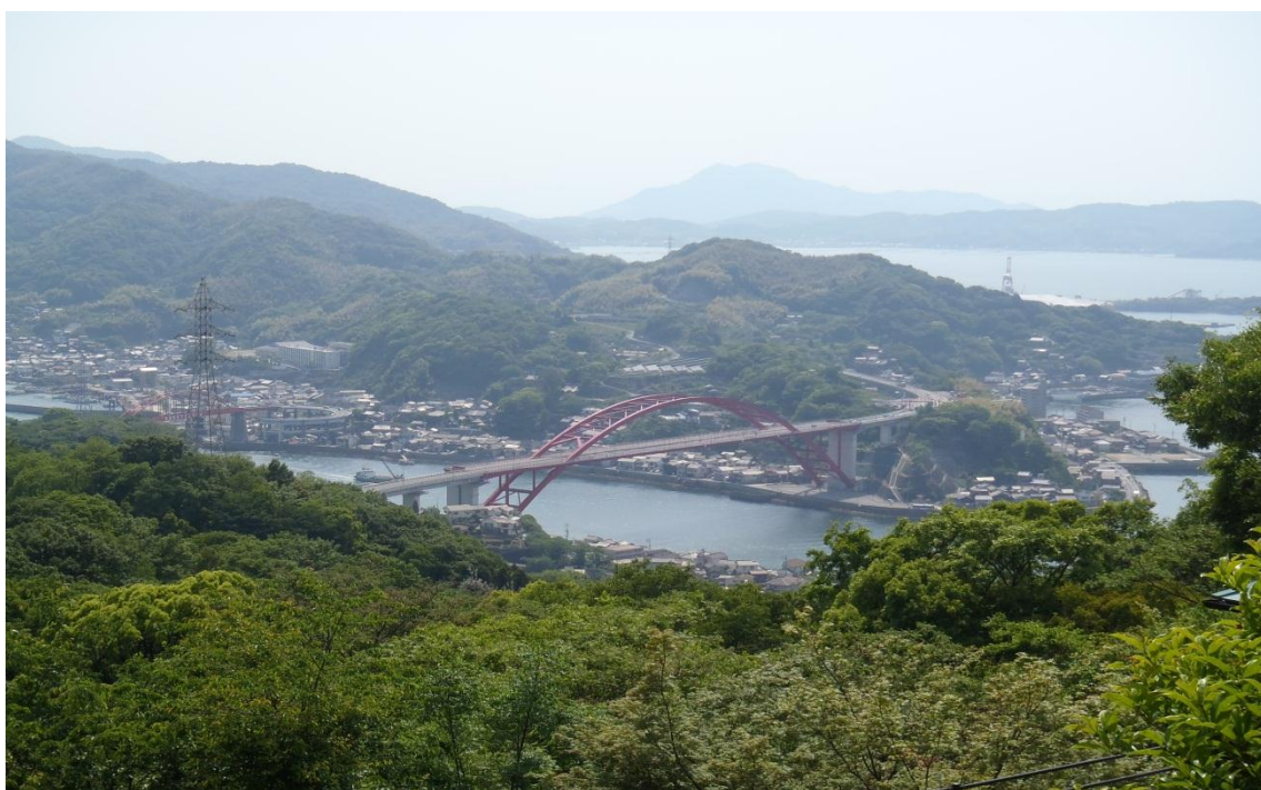
第2 音戸大橋(平成29年4月23日撮影)
