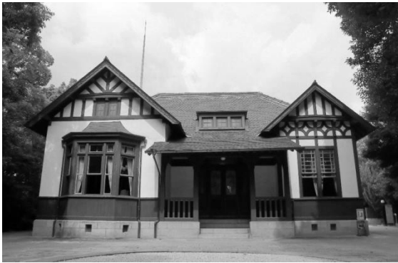
1 旧呉鎮守府司令長官官舎 ※国重要文化財
