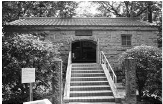
10 呉市入船山記念館旧高鳥砲台火薬庫 ※国登録有形文化財
