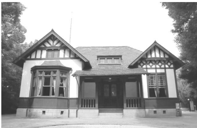
旧呉鎮守府司令長官官舎（国重要文化財）
