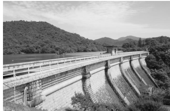
5 本庄水源地堰堤水道施設(堰堤, 丸井戸, 第一量水井, 階段) ※国重要文化財
