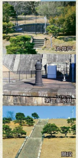
▶「丸井戸」二河川から直接取水した水を一時的に溜めて沈砂し、第一量水井に導く。「第一量水井」丸井戸および取水塔から集水後に浄水場へ水を送り出す。「階段」堰堤北側にある長さ約36mの石造りの階段。
