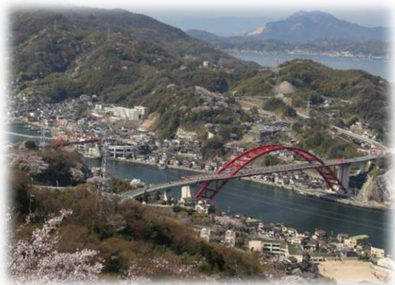
音戸大橋と第二音戸大橋
